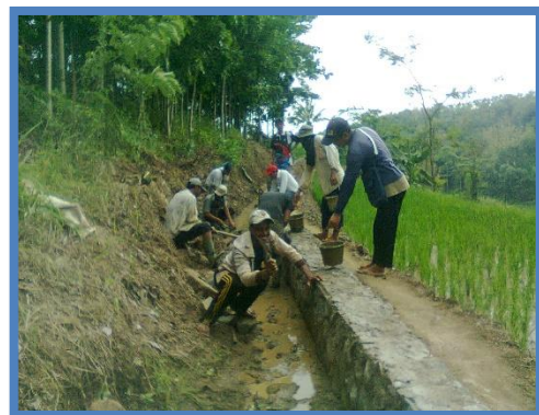
Rehabilitasi Saluran PASANGAN
