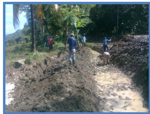
Pekerjaan Sedimen LUMPUR
